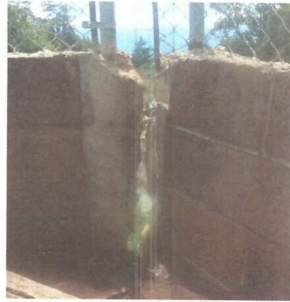
Foto 2: reparación del muro de contención de una esquina de la circulación de la escuela.
