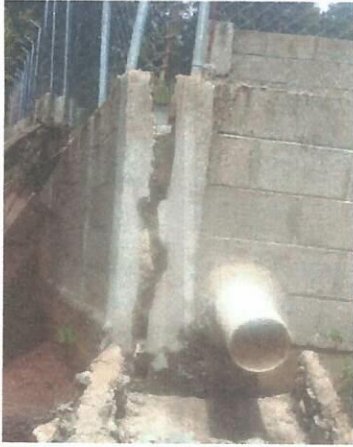
Foto1: Reparación del muro de contención.
