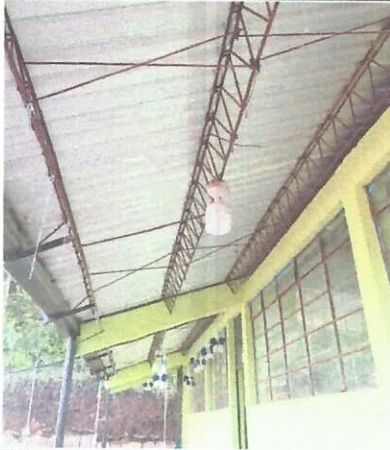
Foto1: Cubierta de lamina calibre 26 troquelada y reparacion de estructura metalica de 2 aulas.
